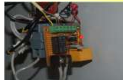
แสดงระบบตรวจจับเหตุการณ์ขัดข้องต่าง
