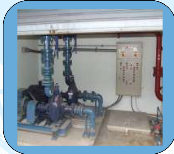
แสดงห้องควบคุมปั้มน้ำและถังเก็บน้ำใต้ดิน
