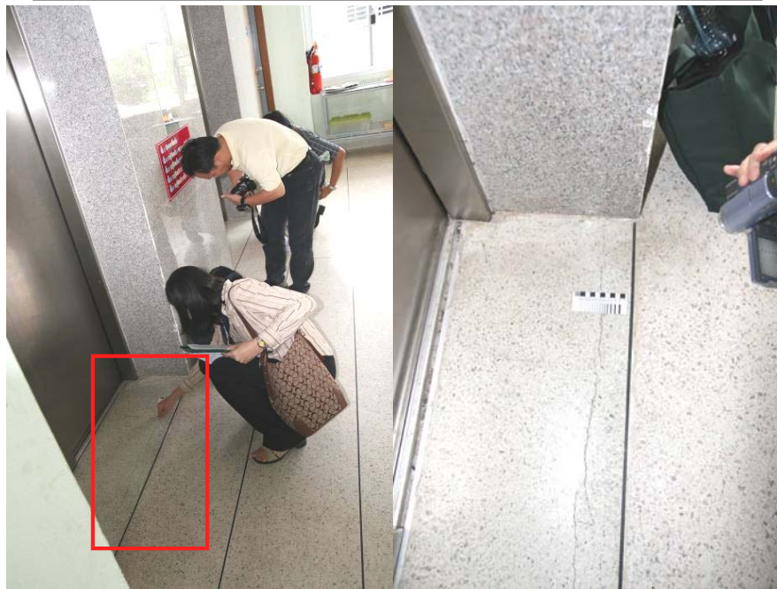
รอยแตกร้าวของคอนกรีตบริเวณพื้นหน้าลิฟท์ชั้น 2 ขนาด 0.8 มม.
