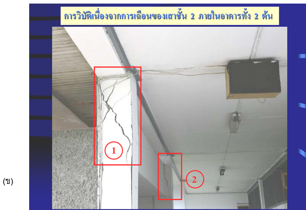
รูปที่ 7 (ก) อาคารโรงเรียนเม็งรัมย์หาราชวิทยาคม เกิดความเสียหายจากแผ่นดินไหวลาว (ข) รอยร้าวทแยงในเสา
