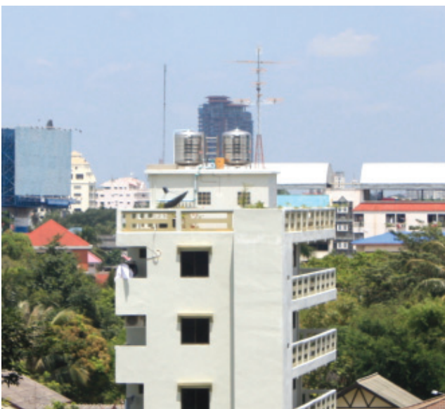
รูปที่ ๖ ถังพักน้ำบนอาคารฟ้าอาคาร อาจมีเชื้อลีสีอีโอเนลลาเจริญได้
