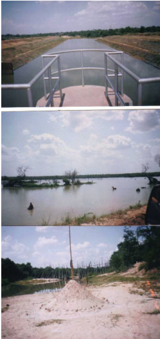
รูปที่ ๖ พื้นที่โครงการชลประทานเหนือฝาย ตัวฝาย และได้ฝาย (ภาพถ่ายจากสถานที่จริง พ.ศ. ๒๕๕๑)
